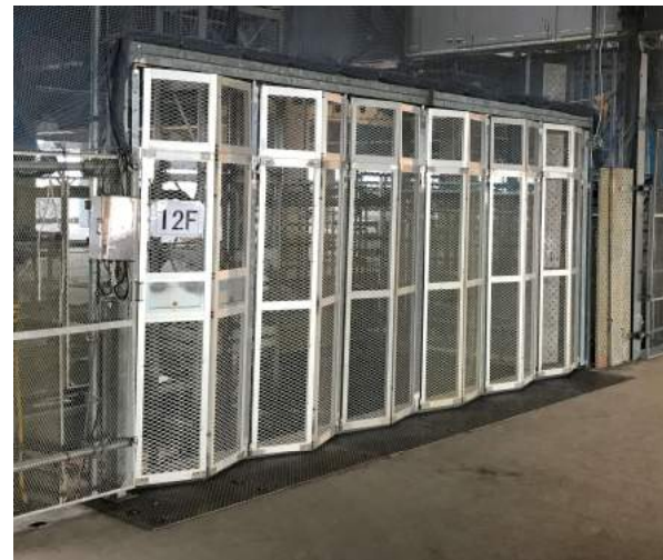
エレベーターの各階扉
